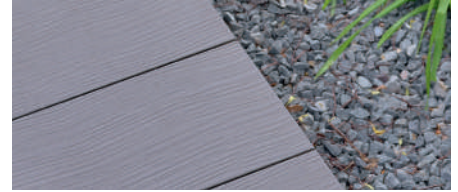
nach Reinigung mit Wasser
